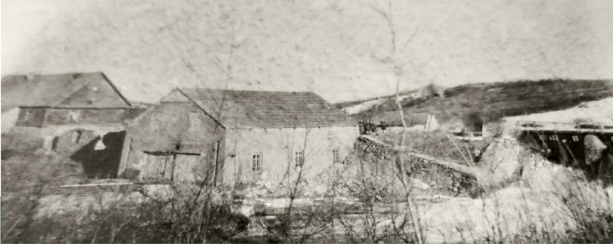
Фота 6. Выгляд месца з боку ракі. На першым плане – будынак электрастанцыі (фабрыкі, млына) з трыма вокнамі па даўжыні тарца, шырокімі дзвярамі тэхнічнага прызначэння з боку Чырвонай гары і замураванымі вокнамі ўверсе над імі. Справа – абрысы плаціны з мостам. : Пры канцы каменнага адгалінавання ад муру плаціны да ўвахода ў будынак прадпрыемства з боку дарогі – купка людзей. За будынкам электрастанцыі – хата. Каля 1957 г. Са збору А. Альхімовіча
